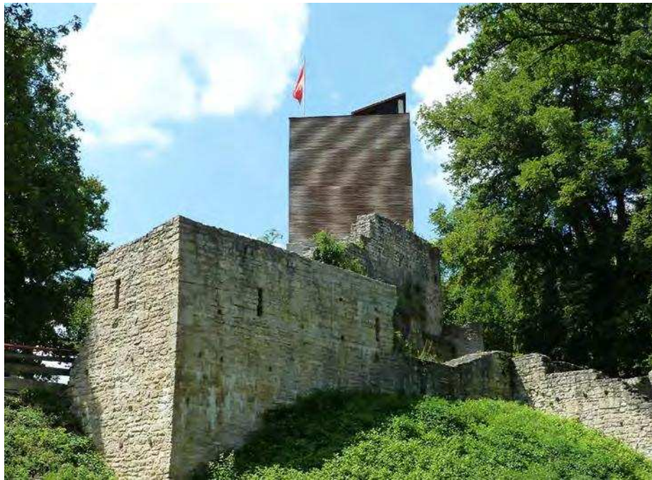
Burgenanlage nach Sanierung Wohnturm Fotografie Stadt Treuchtlingen
