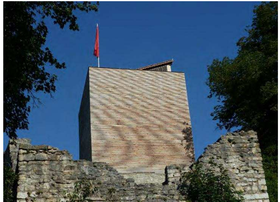
Ehemaliger Wohnturm nach Sanierung Fotografie Stadt Treuchtlingen
