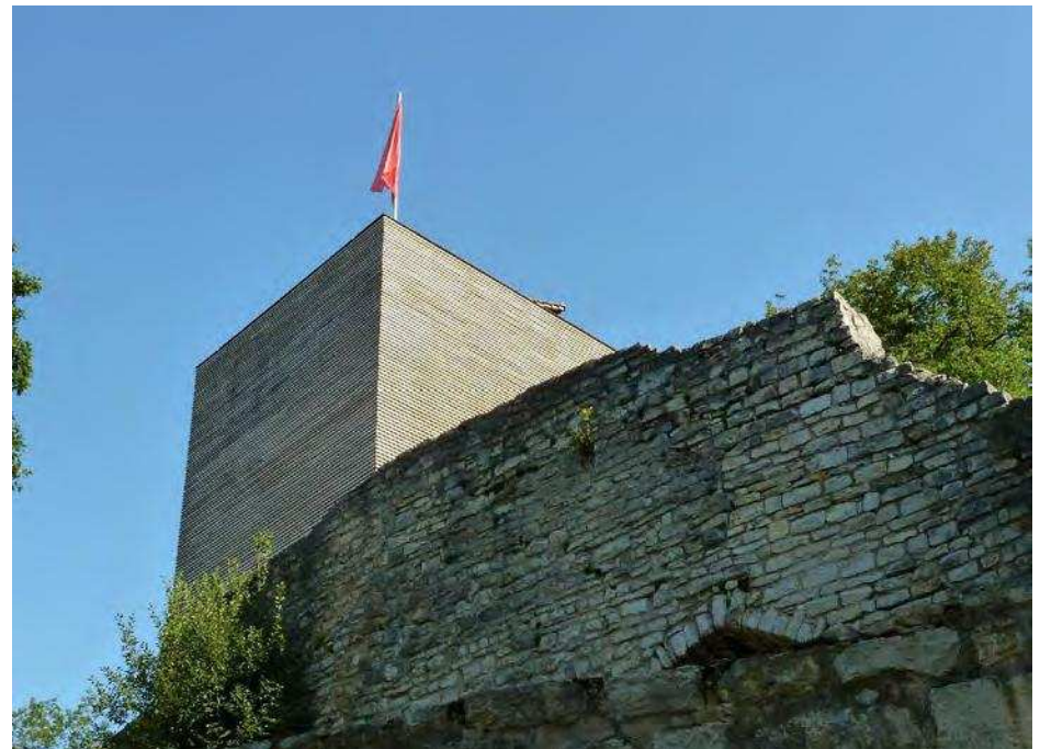
Burgenanlage nach Sanierung Wohnturm Fotografie Stadt Treuchtlingen
