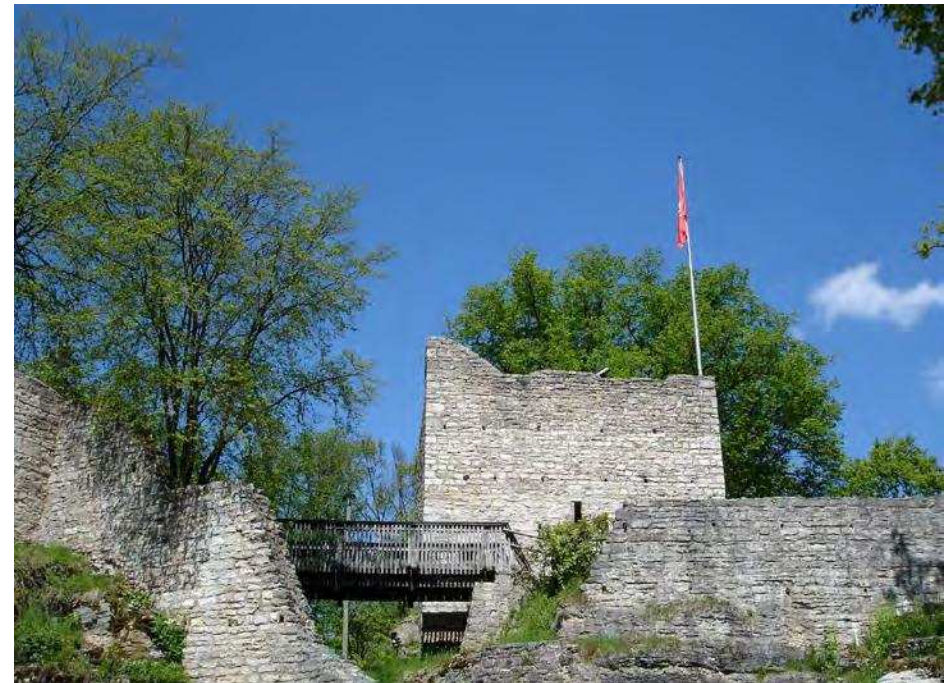
Ruine des ehemaligen Wohnturms Fotografie Stadt Treuchtlingen
