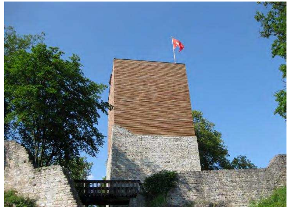
Wohnturm nach Sanierung und Aufstockung Fotografie Stadt Treuchtlingen
